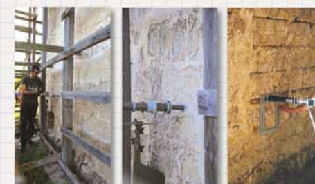
Prove penetrometriche Prova con penetrometro dinamico sulla Parete Est esterna (foto a sin. e al centro) e con penetrometro statico all'interno del vano ipogeo (foto a dx.)
